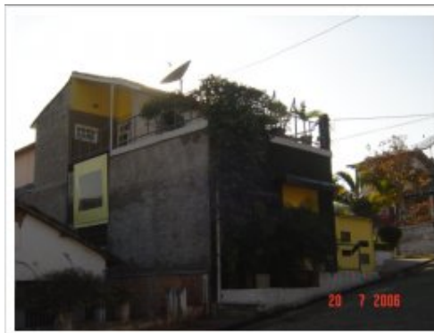
FOTO 4: Vista dos fundos do Imóvel
